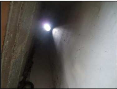
Photo N° 1048 AMIANTE CIMENT - -PLACARDS TECHNIQUES +4 Plafonds Ventilation haute (Fibres- ciment)
